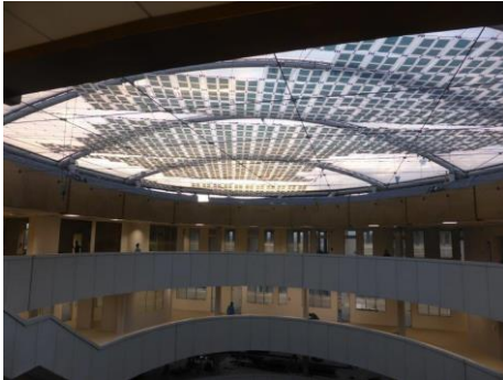
Bild: Die leichte Konstruktion besteht aus 445 individuell designten, teiltransparenten blauen PV-Modulen, die mit Merck's lisicon® OPV Material hergestellt sind, und versorgt die LED Innenbeleuchtung des African Union Peace and Security Building.
