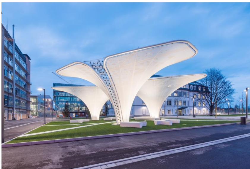
Drei technisch-optimierte OPV-Solar Bäume stehen jetzt repräsentativ in dem neu angelegten Eingangsbereich der Merck KGaA in Darmstadt. (@Bild Merck KGaA, Kristof Lemp)
