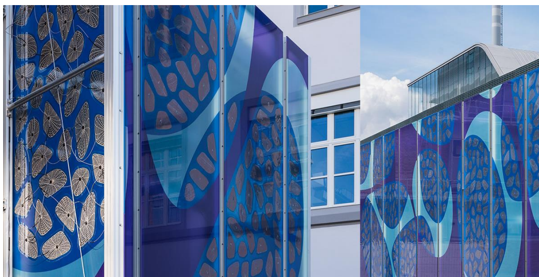
OPV-Module, integriert in farbig-bedruckte, teil-transparente ETFE-Folien.
